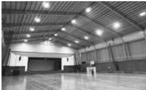
トレーニングセンター改修
